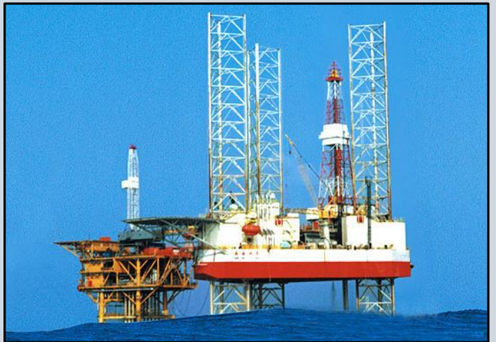
在中国完成钻井平台位置安装
